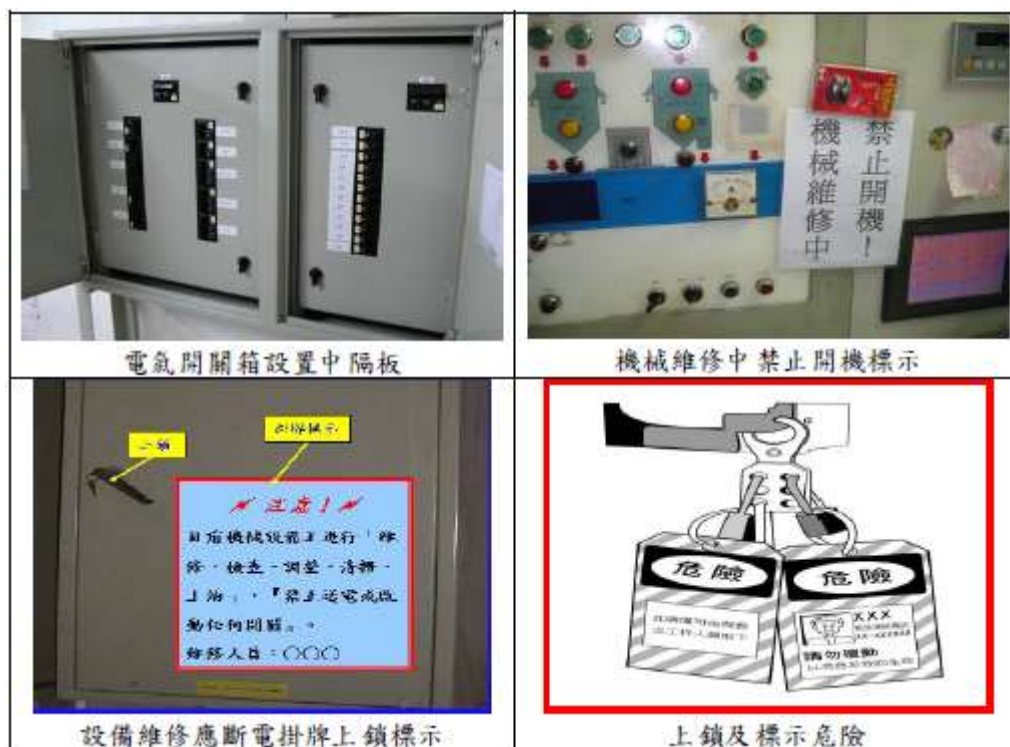
圖 3.2 核准使用之防止感電圖示案例(圖片來源：勞動部 TOSHMS 北區促進會)
